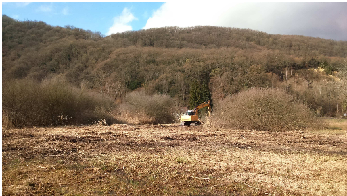
Broyage de saules à la pelle hydraulique marais
