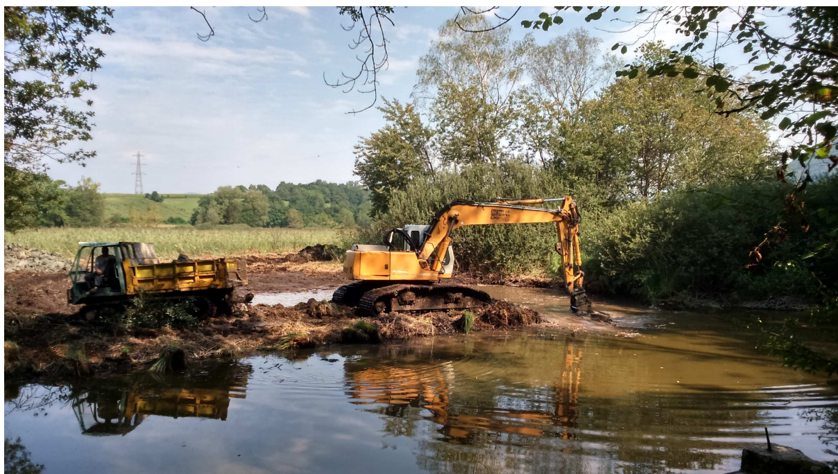
Creusement d'un étang et évacuation des matériaux
